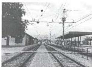
Elektrificirano železniško vozlišče v Celju (foto A. Sore)
