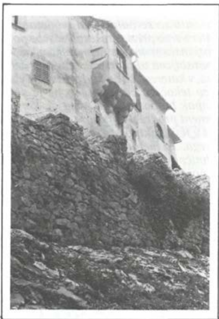
Sanacija grajskega obzidja leta 1979
