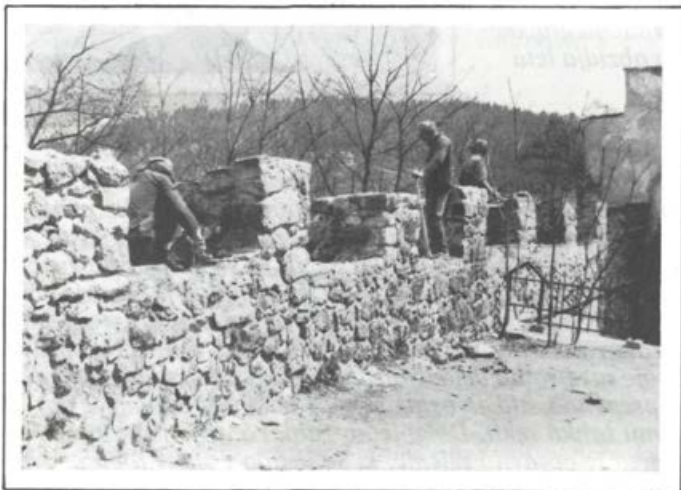
Sanacija grajskega obzidja leta 1979 .
