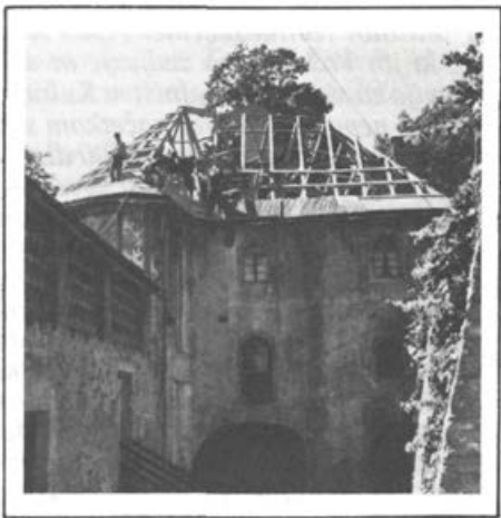
Sanacija ostreš- ja vhodnega stolpa leta 1984
