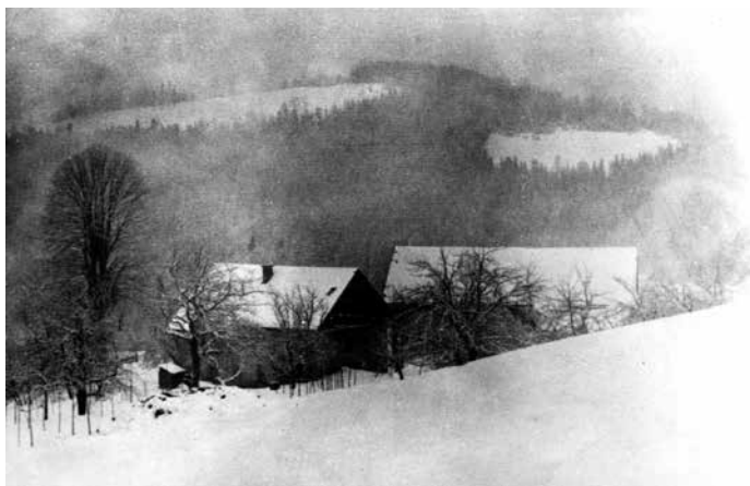
Zavodnje nad Šoštanjem.
