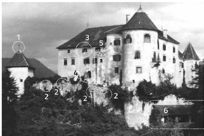
Grad pred prenovno z označenimi spremenjenimi deli: 1. Križ na vrhu kapele. 2. Cevi meteorne kanalizacije, speljane skozi nekdanje strelne line v obzidju. 3. Podstrešna okna s polkni. 4. odprtina v steni – danes zazidana. 5. Stolpič s stranišči – danes odstranjen. 6. Lope, prislonjene ob južno obzidje.
