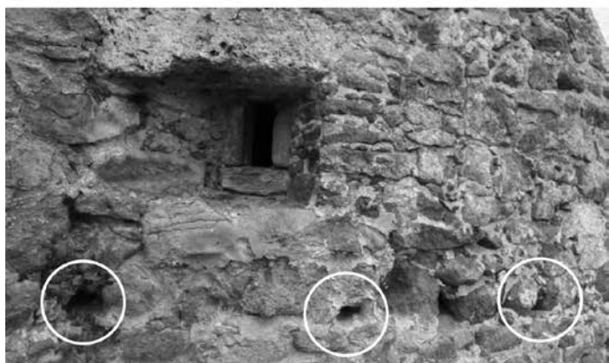
Sledi opor za zidarske odre (brunčnice) na stolpu s kapelo.
