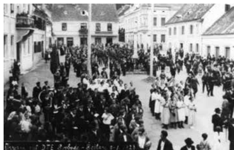
Šoštanj, 9. september 1923. Okrožni zlet DTE-Delavske telovadne enote Svobode Šoštanj.
