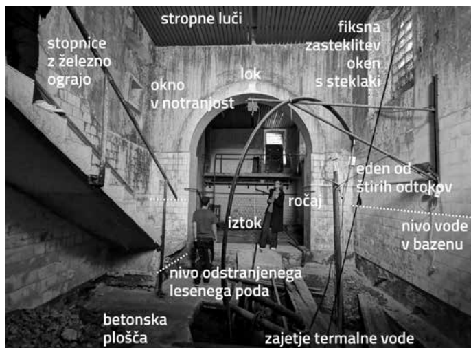
V nekdanjem bazenu – pogled izpod balkona. Foto: R. Poles, 2022.
