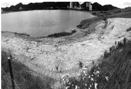
Del aktivne cone Družmirske kotanje: vidni so porušena razpoka in erozijski jarki na izpostavljenem sedimentu. Foto: Jošt Kodrič.
