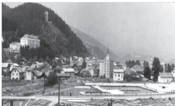
Gradnja letnega kopališča leta 1965.
